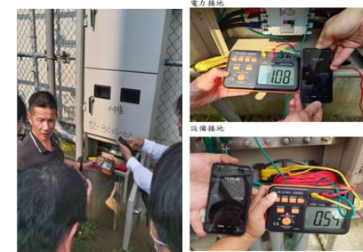
中繼機房接地電阻驗測
